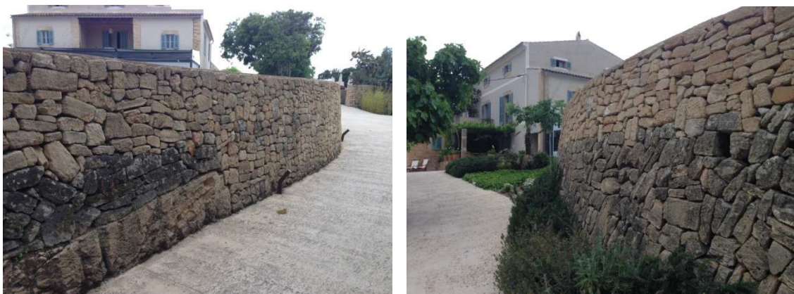
Paredes de la era restauradas reproduciendo su estado original.
