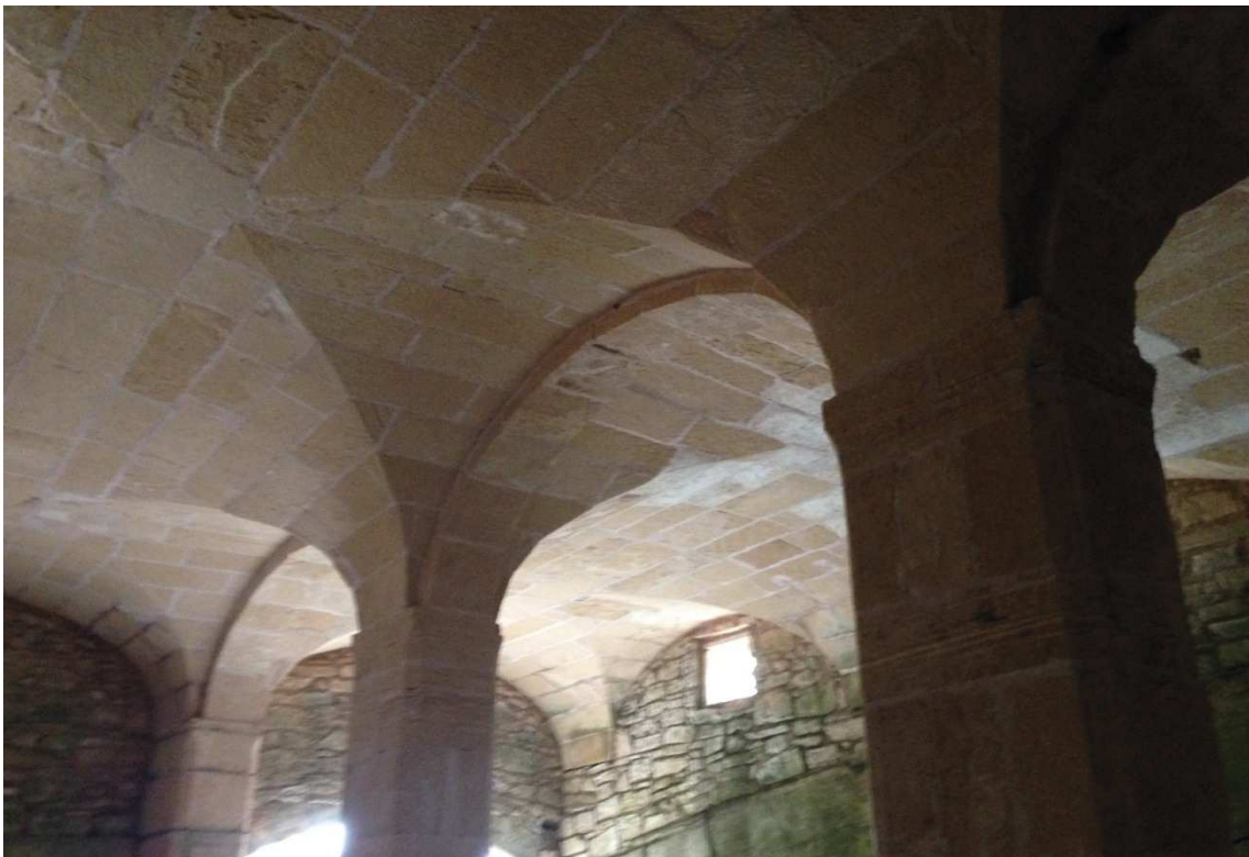
Imagen correspondiente a las bóvedas de marés que conforman el techo del celler.
