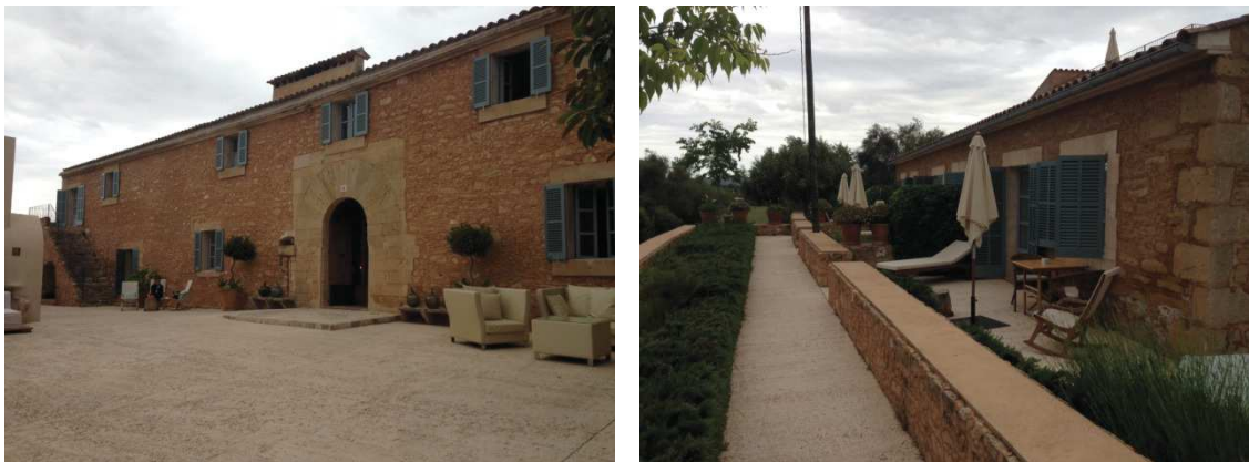
Imágenes correspondientes a la edificación principal y a la denominada edificación anexa A.
