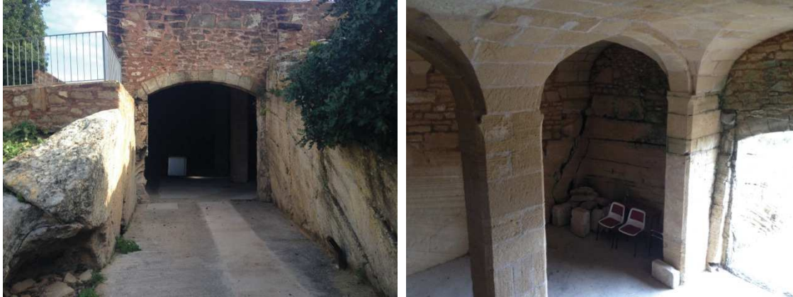
Acceso y detalle del techo de marés del celler presente en Son Jaumell.
