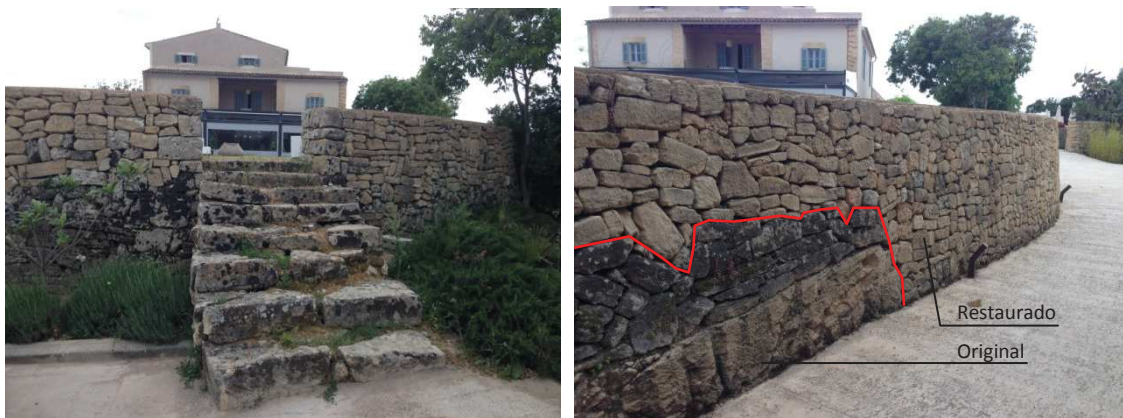
Acceso a la era desde el aparcamiento y detalle de la restauración efectuada en su perímetro.
