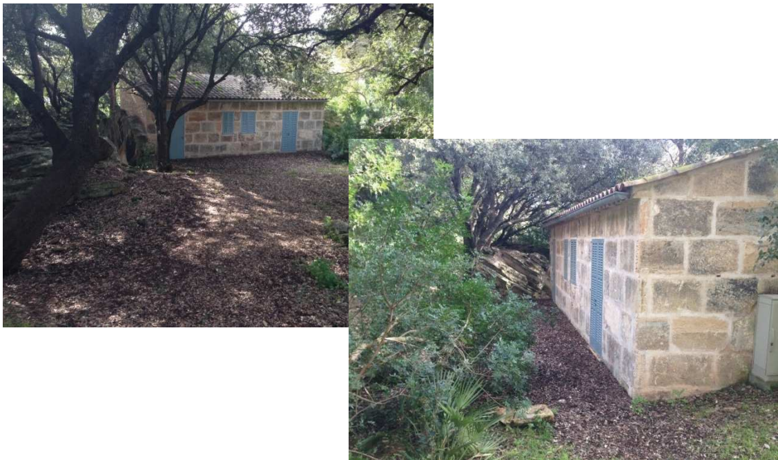
Vistas correspondientes a la parte trasera de la Edificación Anexa D.
