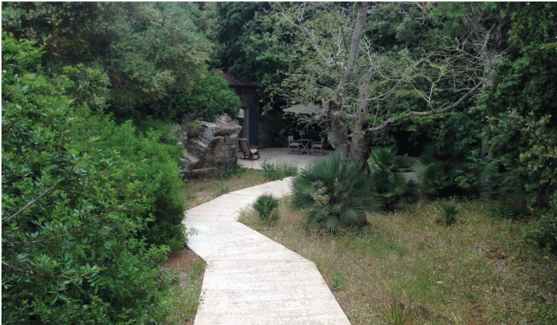
Imagen del sendero de acceso a la Edificación Anexa D (al fondo de la imagen).
