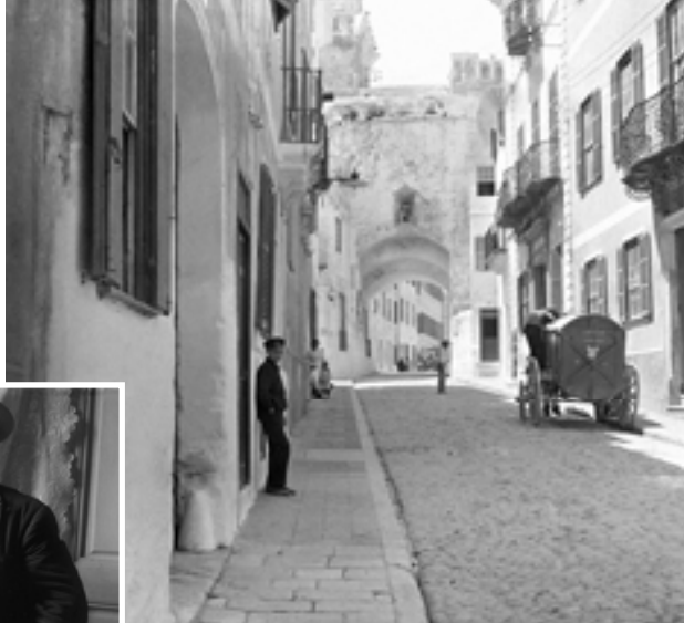
Portal de Sant Roc, 1915, Maó
